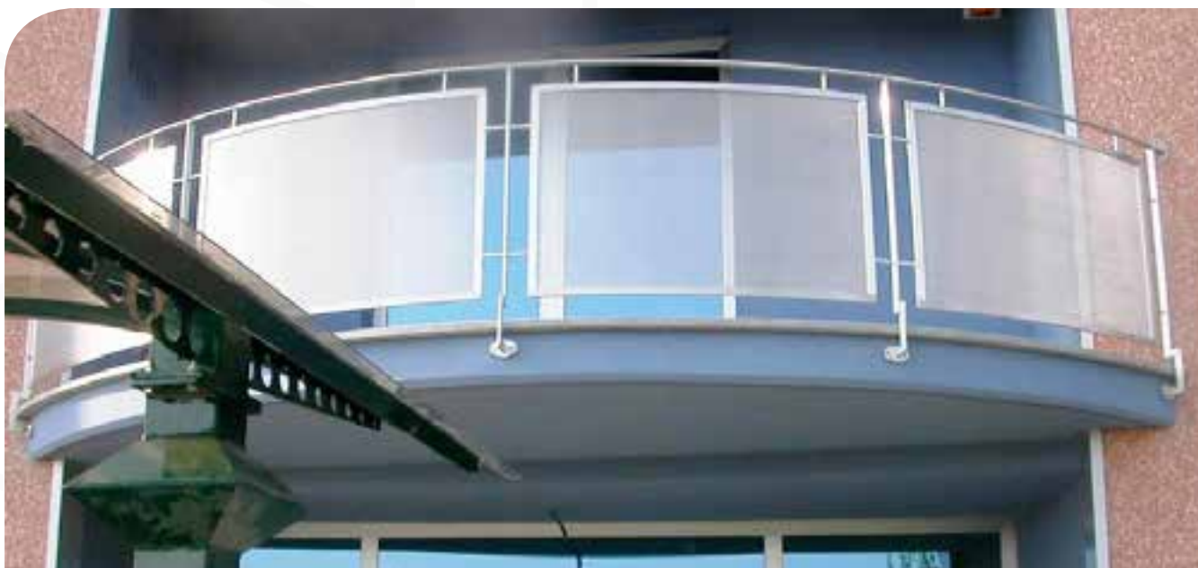
▲ Parapetto in acciaio inox con lamiera microforata
