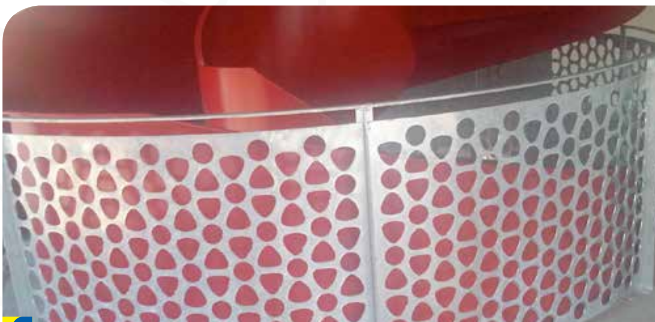
▲ Parapetto in lamiera zincata lavorata al Plasma
