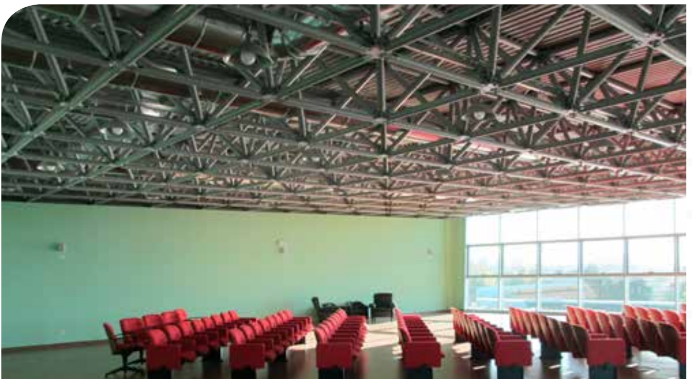
▲ Soffitto strutturale realizzato con travatura reticolare
