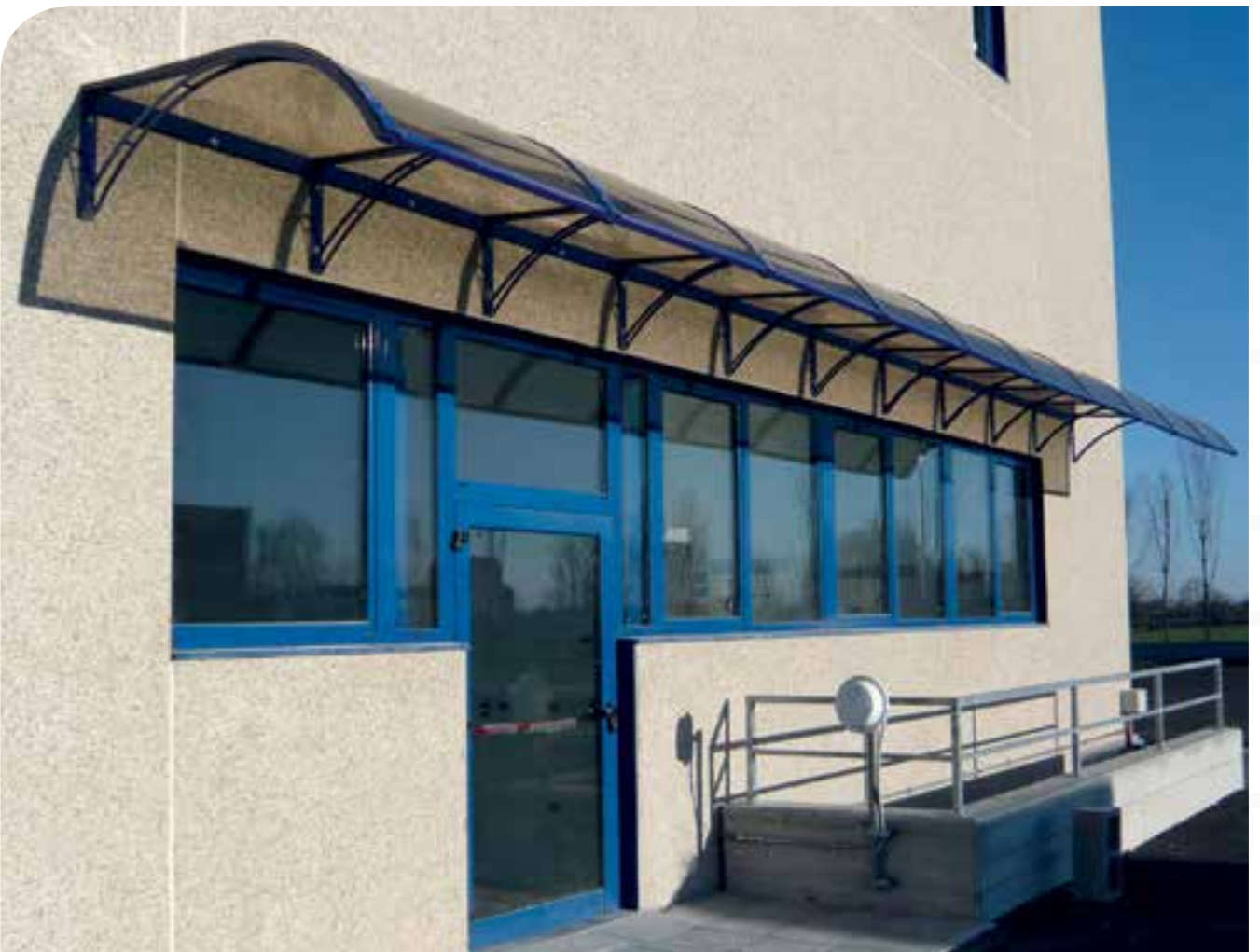
▲ Pensilina in acciaio con copertura in polycarbonato e serramento a nastro in alluminio con porta pedonale inserita
