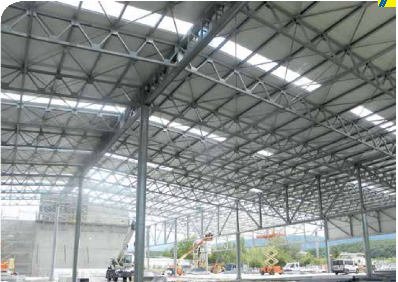
▲ Struttura in ferro per capannone
