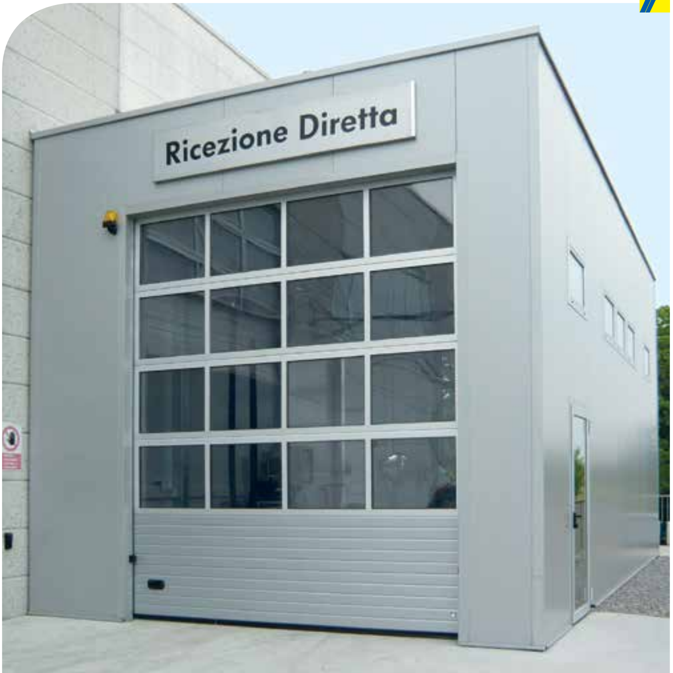
▲ Box in pannello realizzato con carpenteria metallica di sostegno, portone sezionale automatico costituito da pannelli full vision
