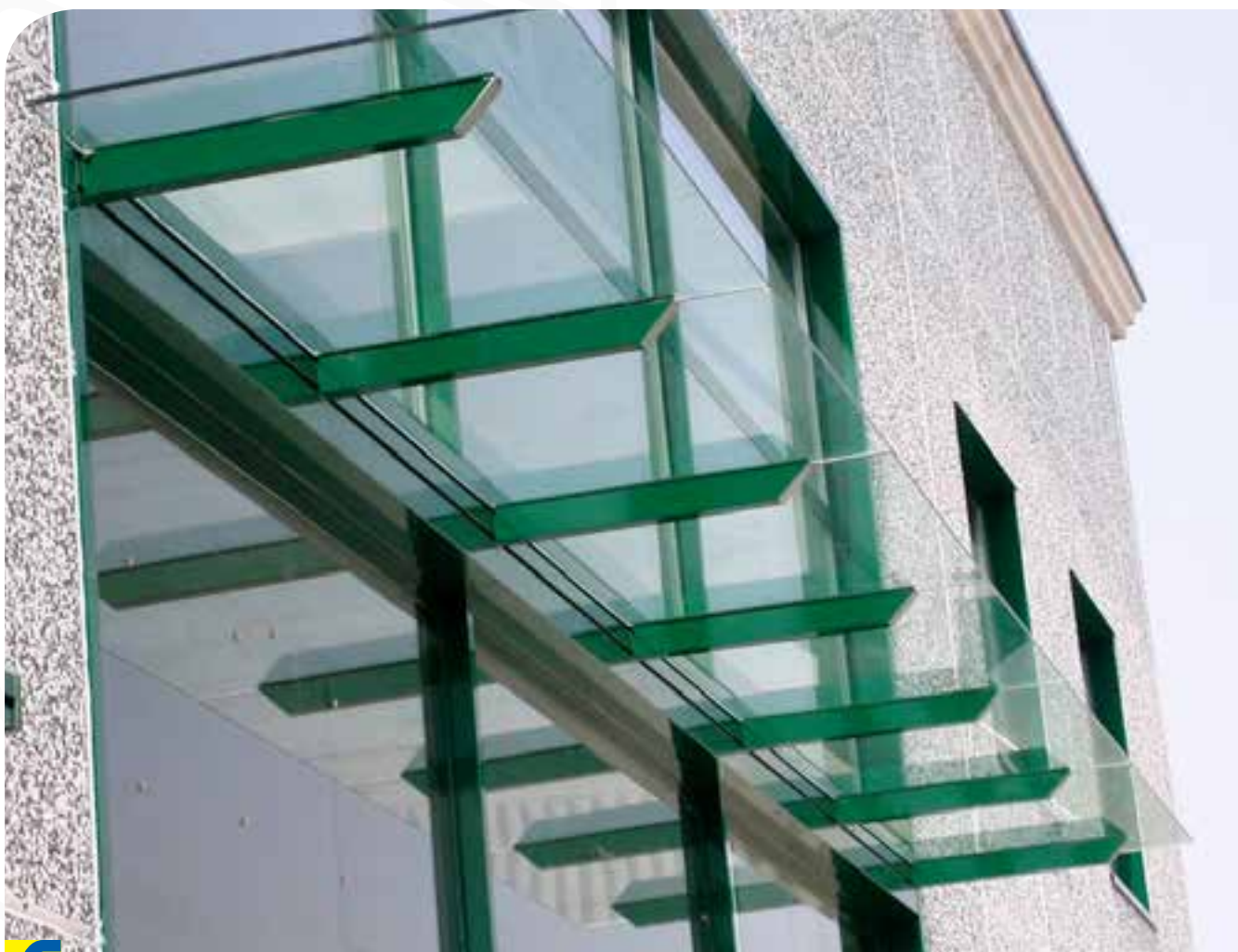
▲ Pensilina in acciaio e copertura in vetro
