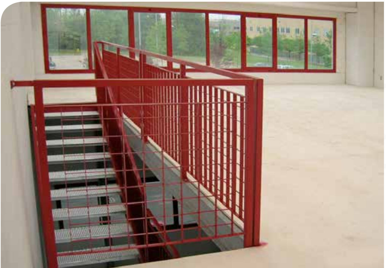
▲ Parapetto in acciaio zincato verniciato a polvere e serramento in alluminio
