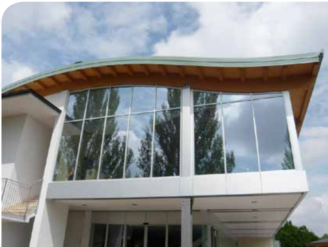
▲ Vetrata con serramenti in alluminio a taglio termico con forma irregolare
