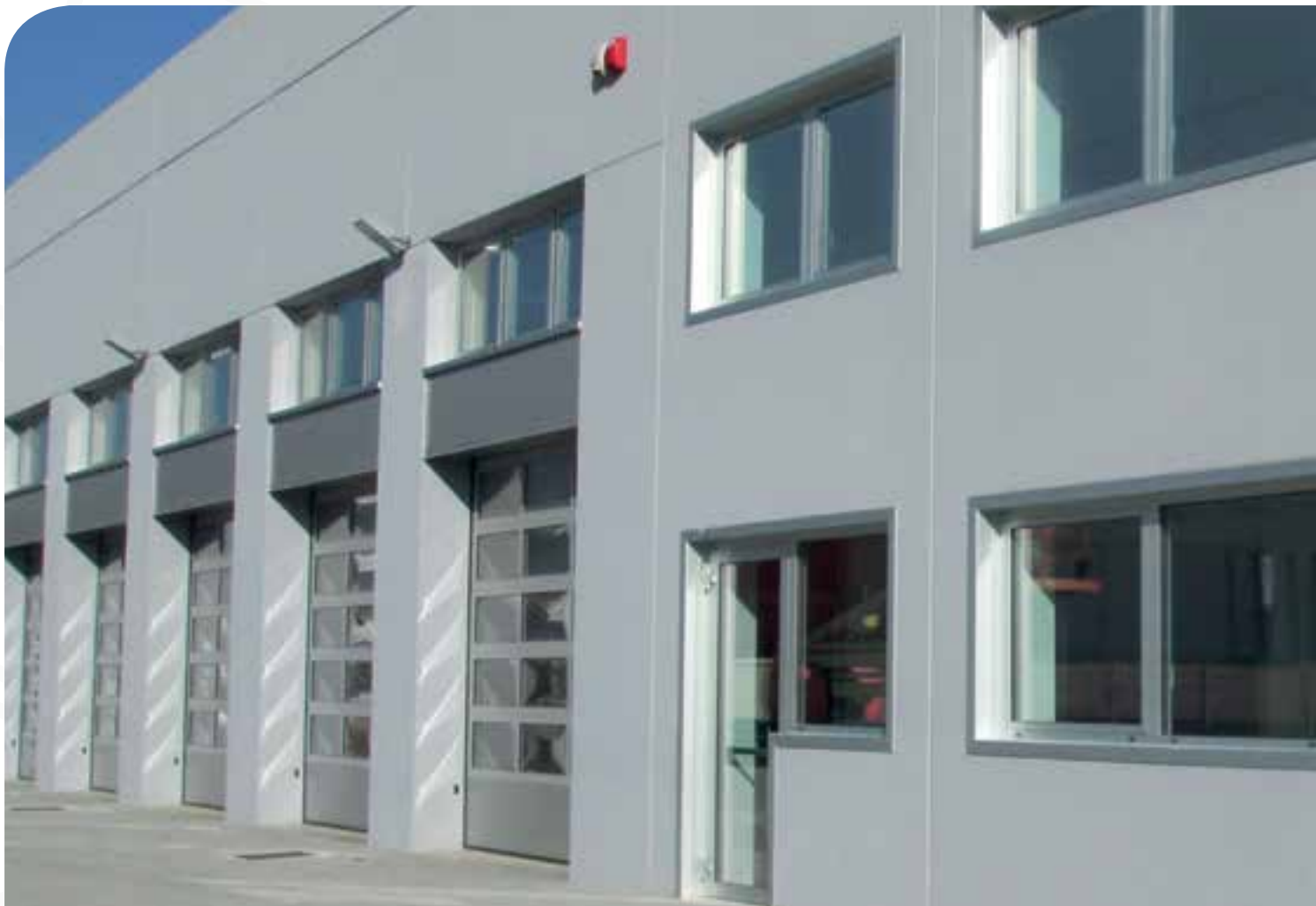
▲ Realizzazione eseguita con portoni a libro, portoni sezionali e serramenti di varie tipologie
