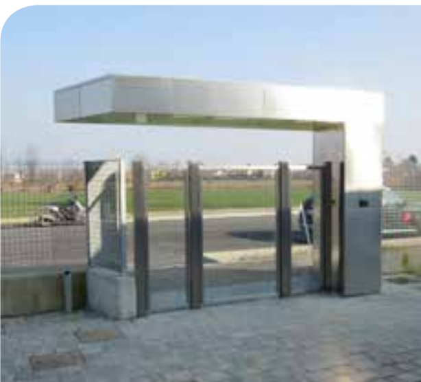
Ingresso pedonale in acciaio Inox e vetro
