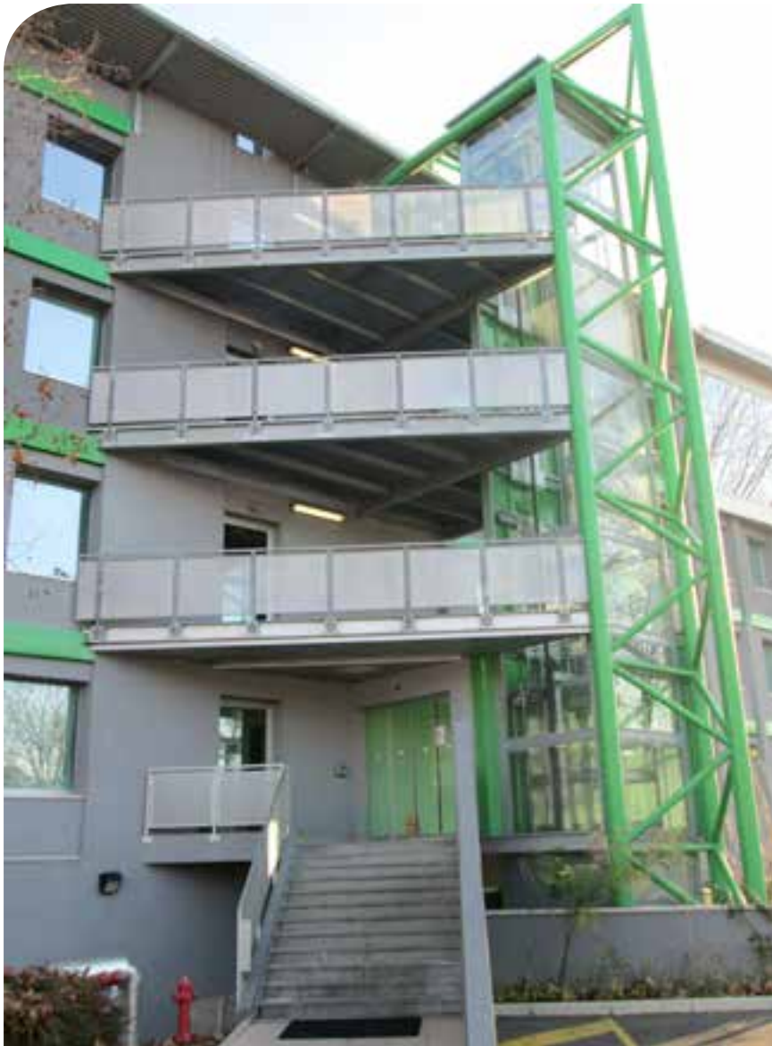
▲ Struttura in acciaio e gabbia protezione ascensore
