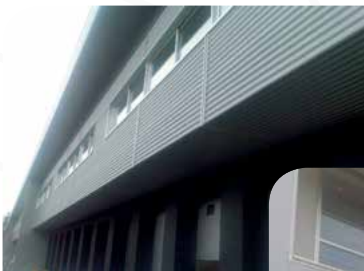
Struttura in acciaio zincato, tamponamento con pannelli sandwich coibentati e inserimento di serramento a taglio termico
