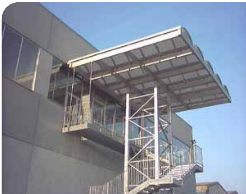
▲ Scala d'emergenza e pensilina di copertura
