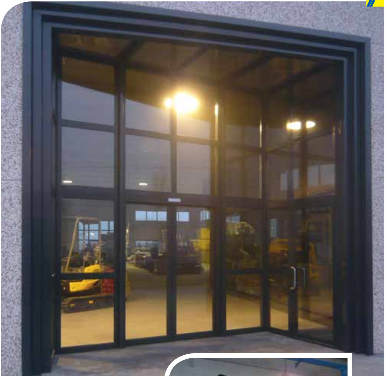
▲ Bussola in alluminio a pianta triangolare vista da esterno/interno, realizzata con profili facciata montanti e traversi
