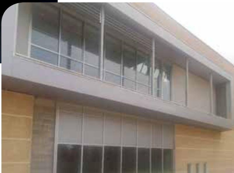
Struttura in acciaio zincato, tamponamento con pannelli sandwich coibentati e inserimento di serramento a taglio termico
