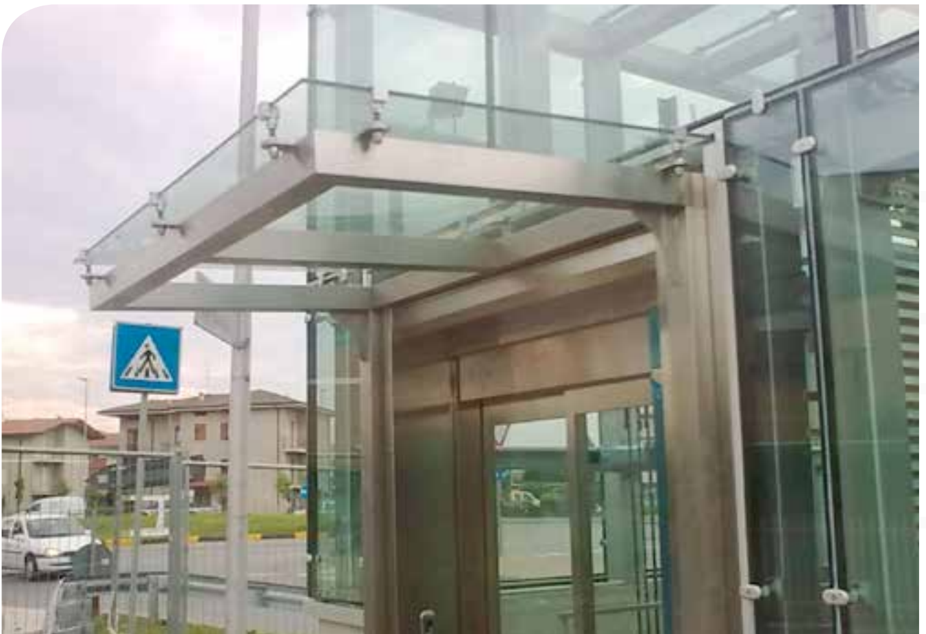
▲ Pensilina di accesso in acciaio inox con vetro temperato
