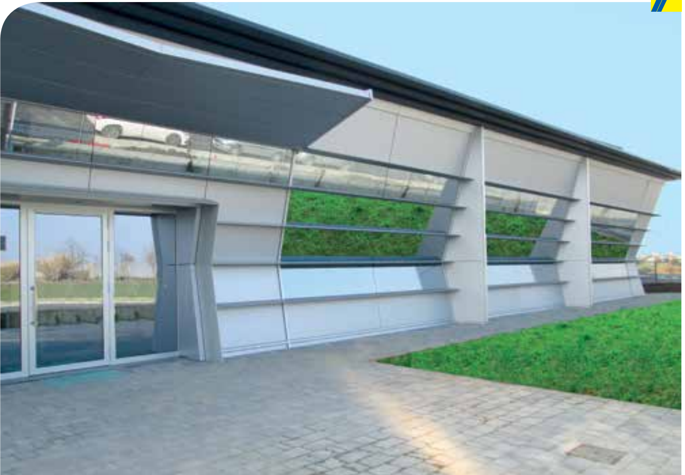
Facciata continua inclinata su 2 assi con vetro Stop Sol realizzata con rivestimento in Alucobond
