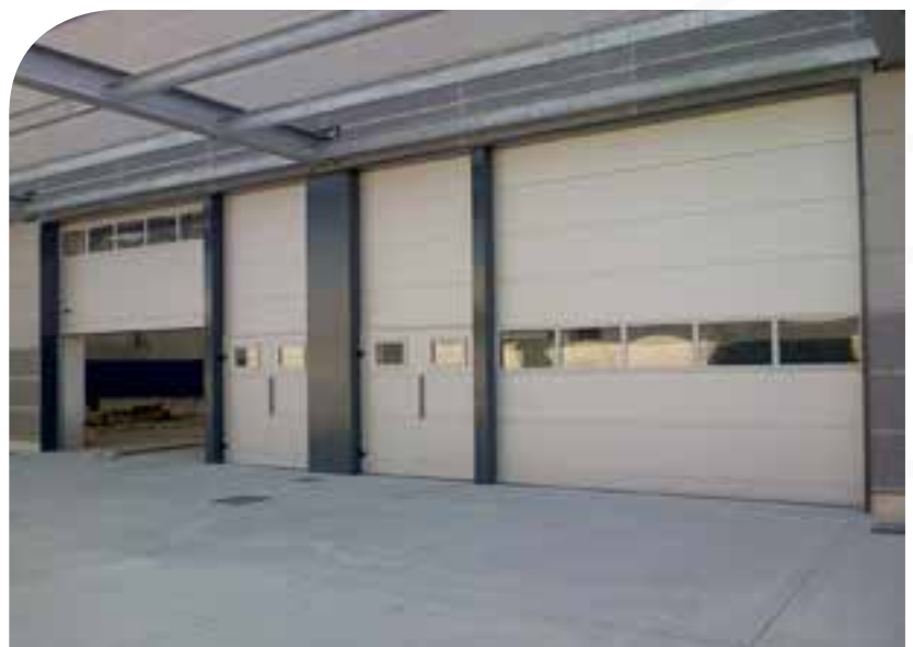
▲ Portone sezionale industriale e uscite di sicurezza
