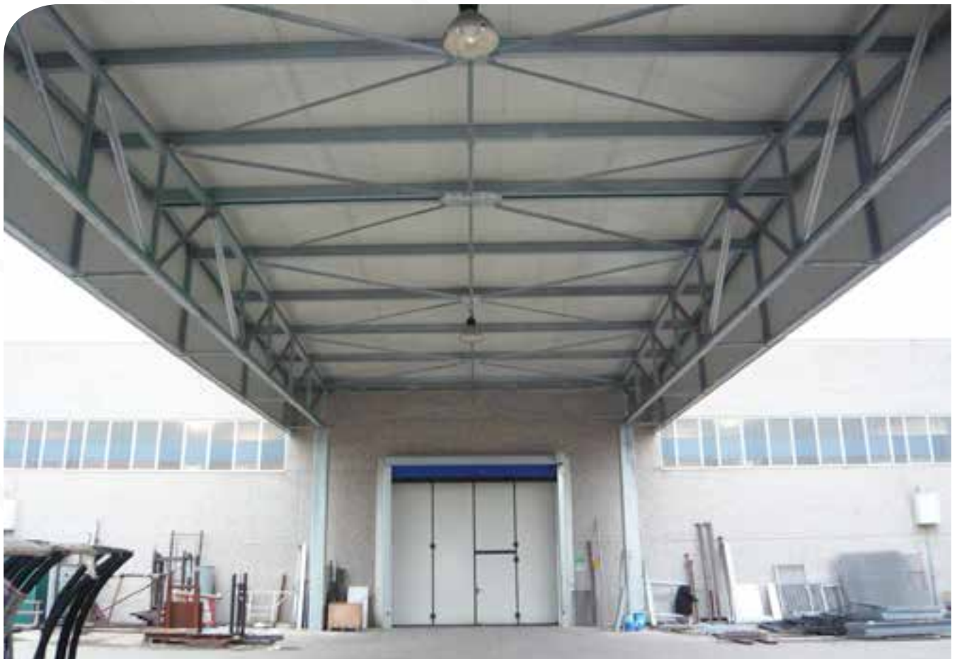
▲ Copertura di raccordo in acciaio
