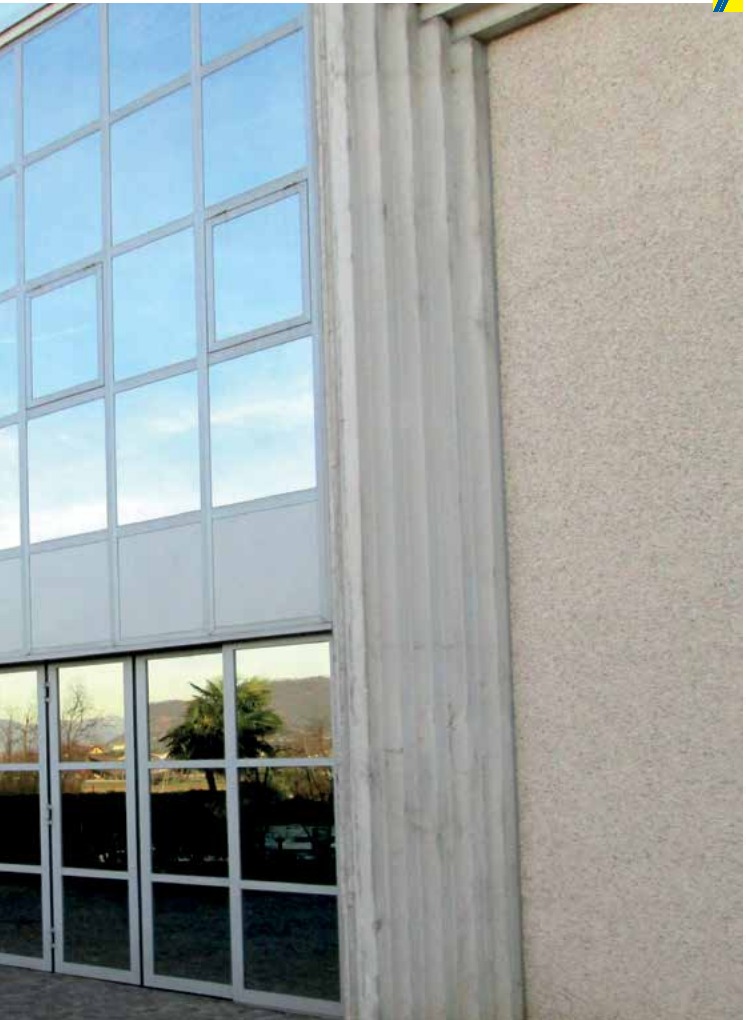
▲ Facciata continua in montanti e traversi completata con porte e portoni a libro costruiti in ante intelaiate interamente vetrate
