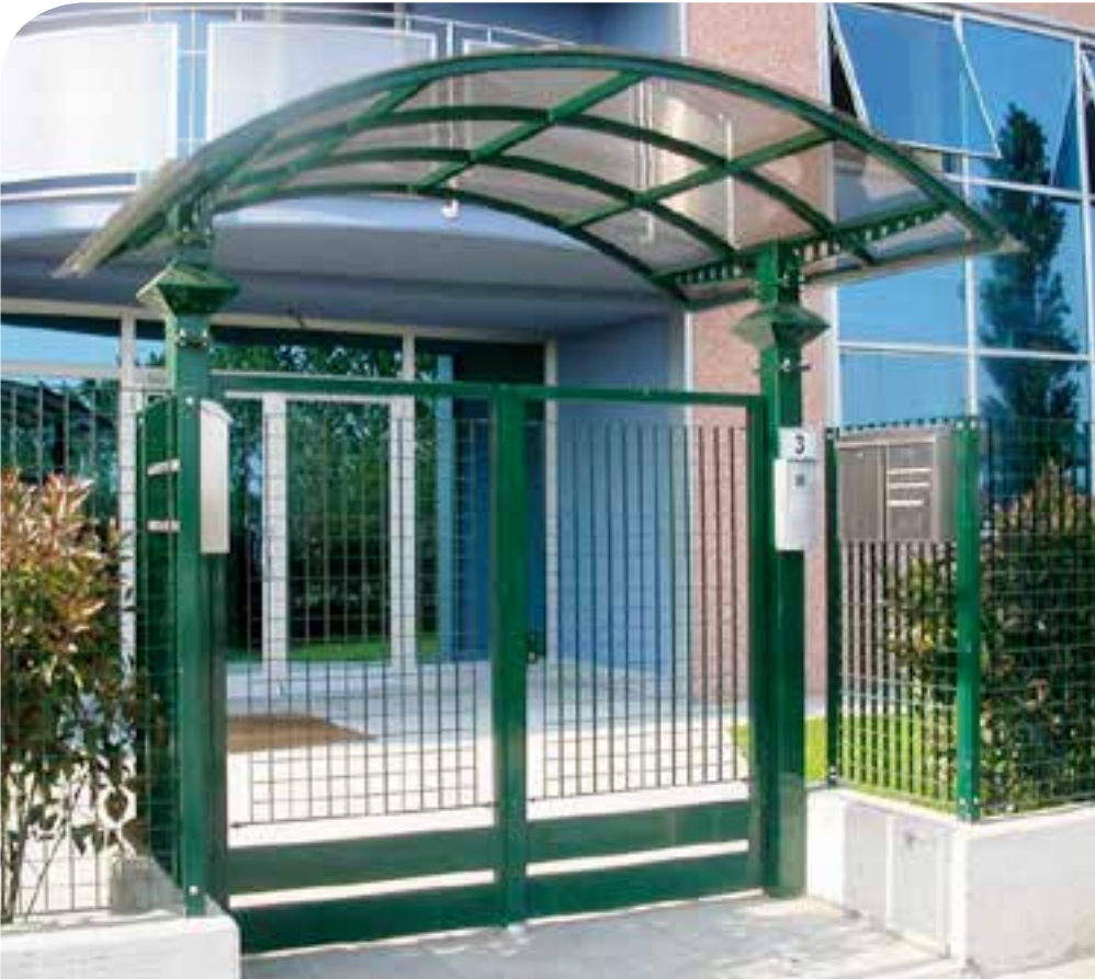
▲ Cancelli a 2 battenti in acciaio con grigliato elettrosaldato, recinzione e pensilina
