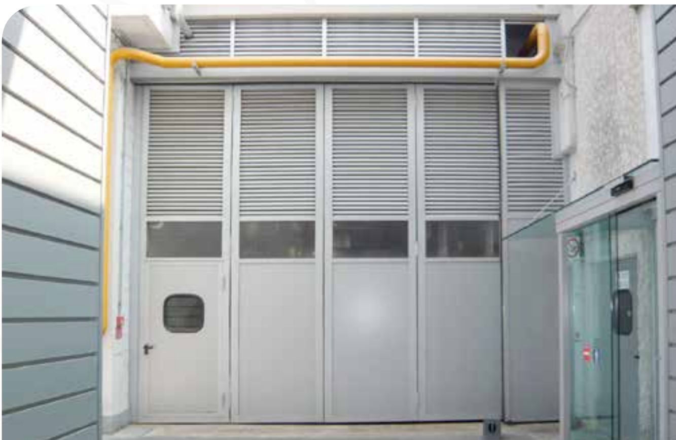
▲ Portone a libro modello Frame Air composto da ante intelaiate complete di alettatura per l'areazione
