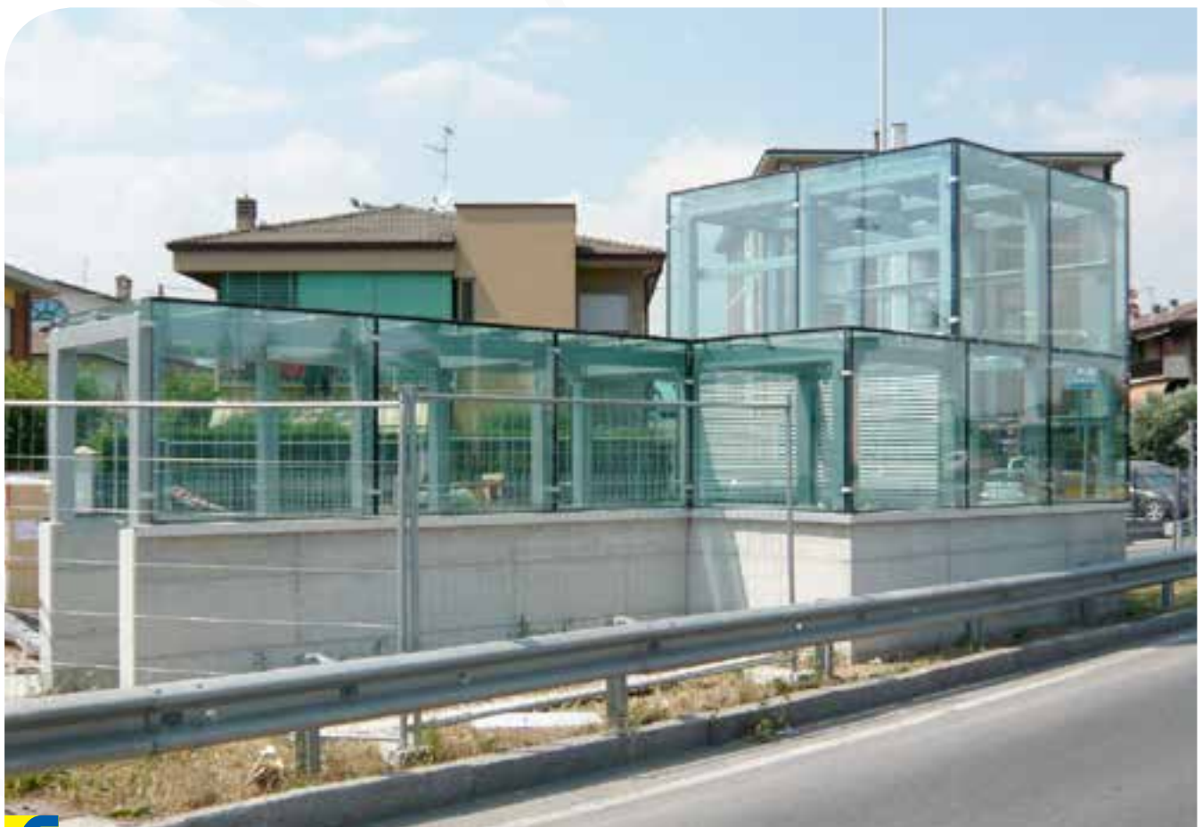
▲ Struttura in ferro per torre ascensori con rivestimento in vetro strutturale
